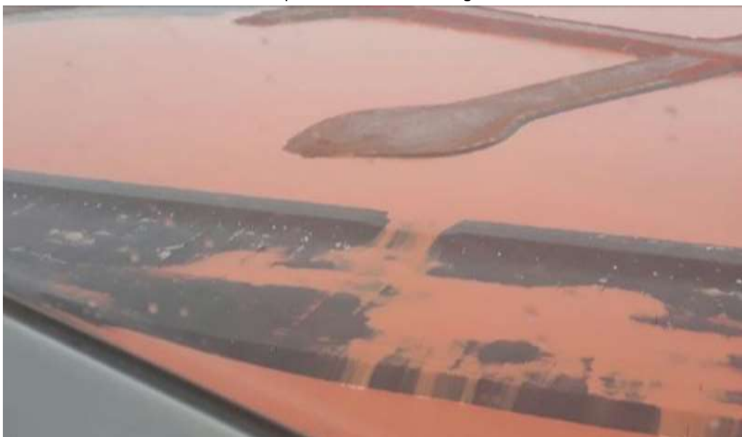
Figura 05- Sobrevoio da área do DRS2, com evidência de extravasamento pelo topo do talude da bacia para o canal de drenagem
