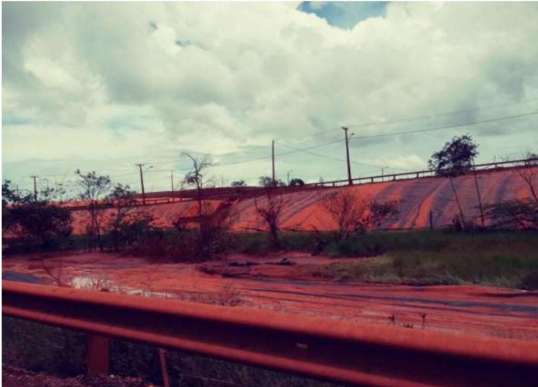
Figura 04- Evidências de transbordo de efluentes das bacias de resíduos da Hydro (DRS1)
