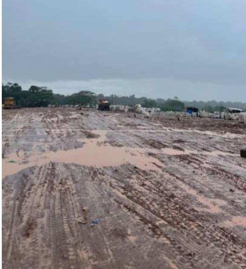
Figura 07- Via situada na comunidade Bom Futuro com acúmulo de lixo ao redor
