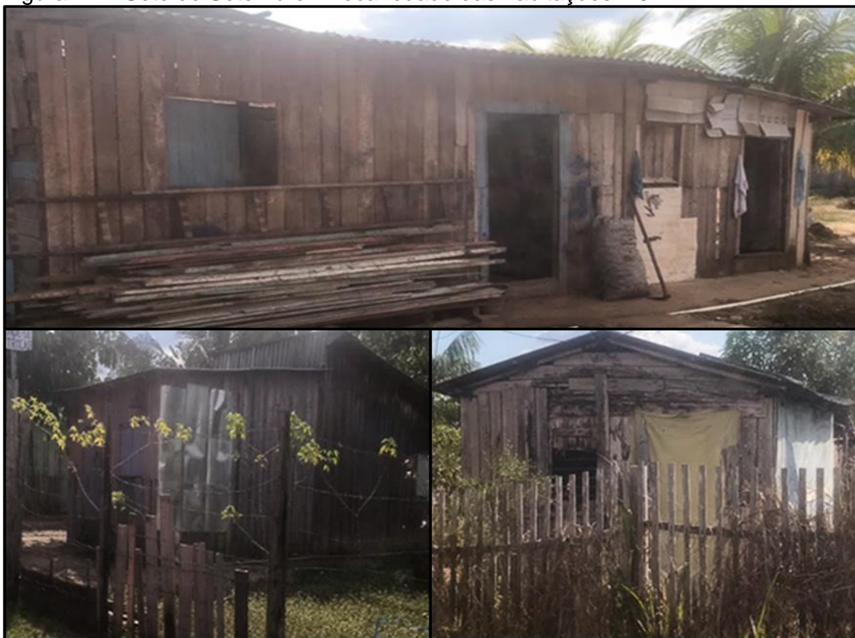
Figura 21 – Sete de Setembro. Precariedade das habitações. 2022
