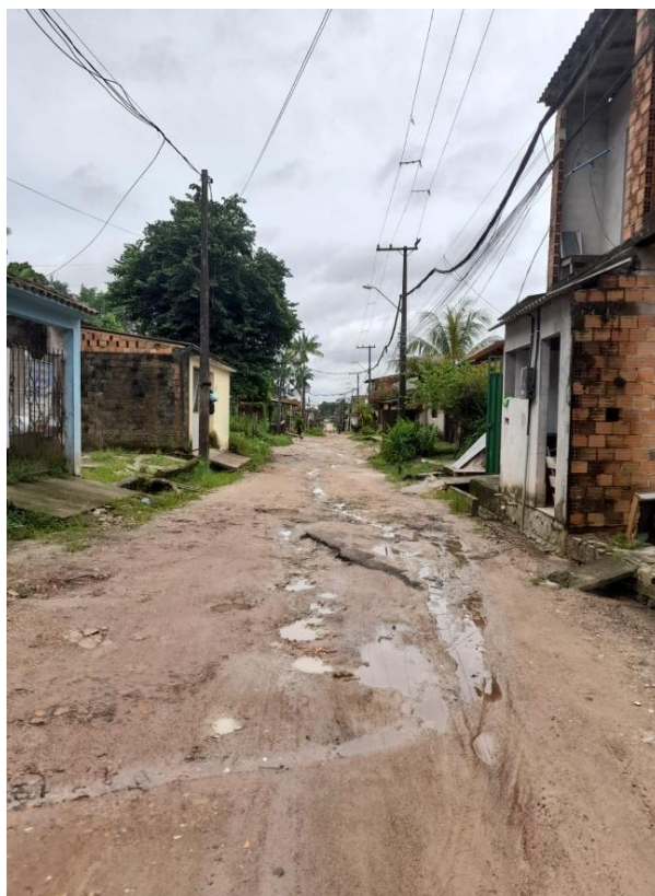
Figura 6: Rua do “L”, Ocupação Tocantins
