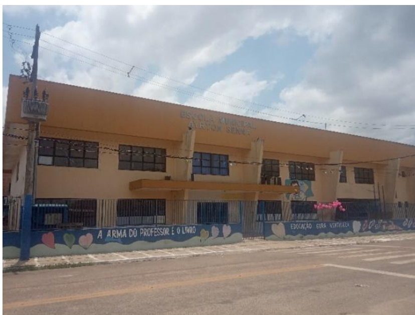
Figura 15: Escola Municipal Ayrton Senna, Ocupação Tocantins
