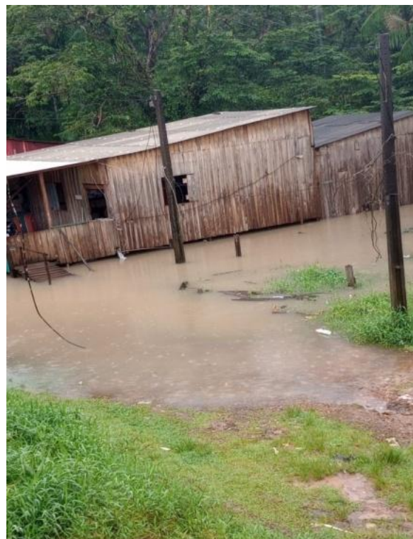
Figura 18: Precariedade de moradia na Rua Beira Rio
