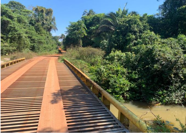
Foto 04: Acesso antes da portaria da Mina N4
