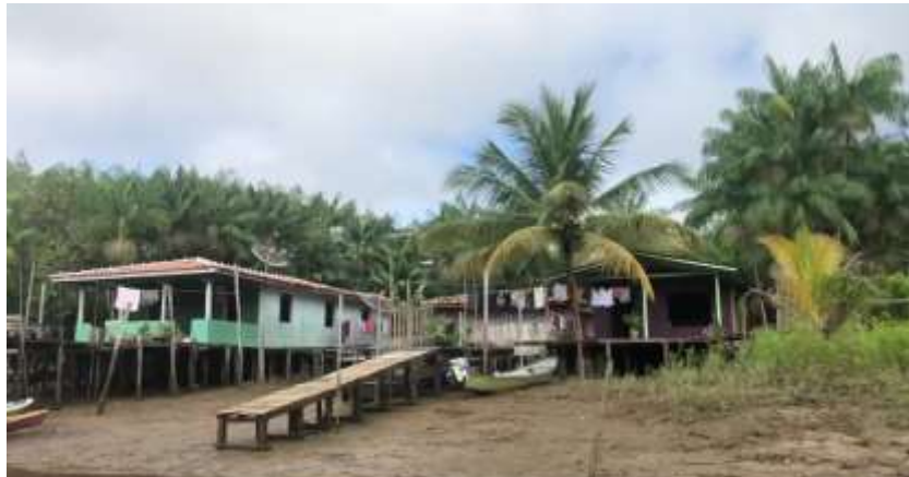
Figura 19: Casas no Pacuí de Cima ligadas por pontes de madeira e troncos de açazeiros.
