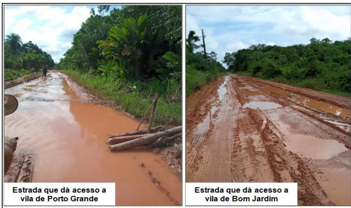
Figura 13. Vias de deslocamento para a sede das vilas de Porto Grande e Bom Jardim, Cametá-PA - 2021.
