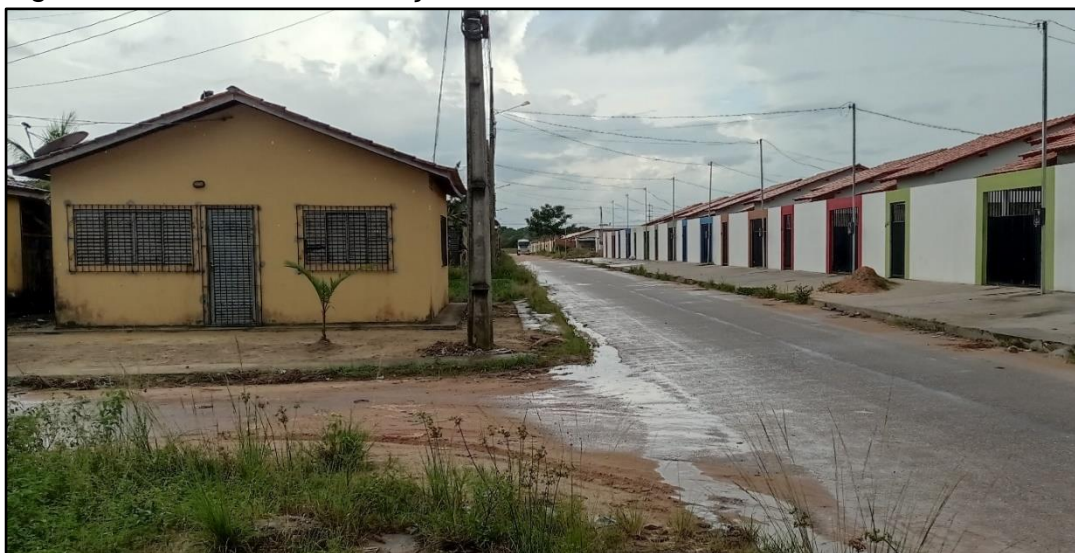
Figura 17: Castanhal. Habitações fracionadas e Faixa 1 lado a lado. 2022.
