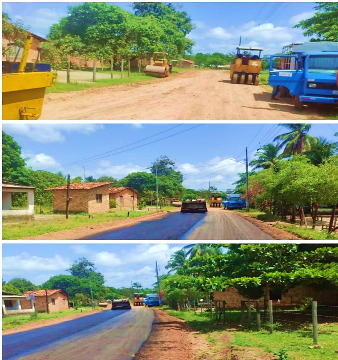
Figura 25 – Asfalto na comunidade quilombola Caldeirão
