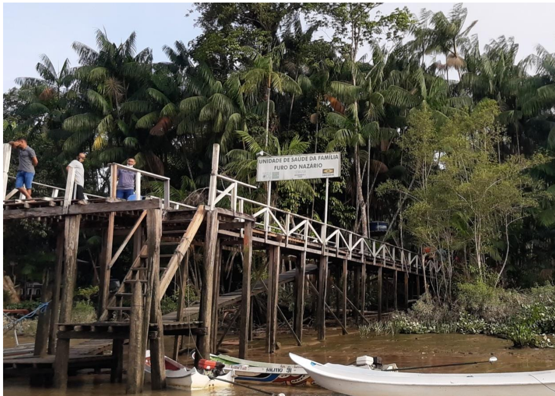
Figura 15 - Acesso à unidade de saúde da família da comunidade.
