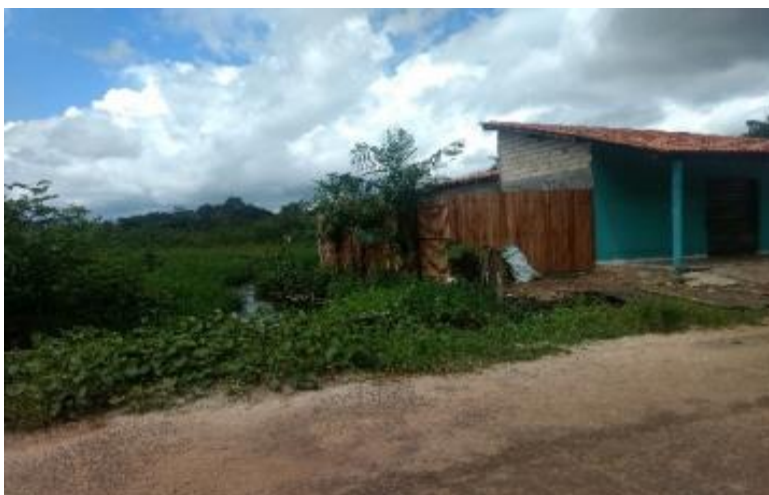
Figura 40 – Construção na margem direita do igarapé Garrafão, na Rua Carlos Gomes
