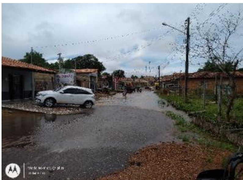
Figura 36 – Inundação do leito maior causada pela cheia do igarapé no centro da cidade (final de abril)
