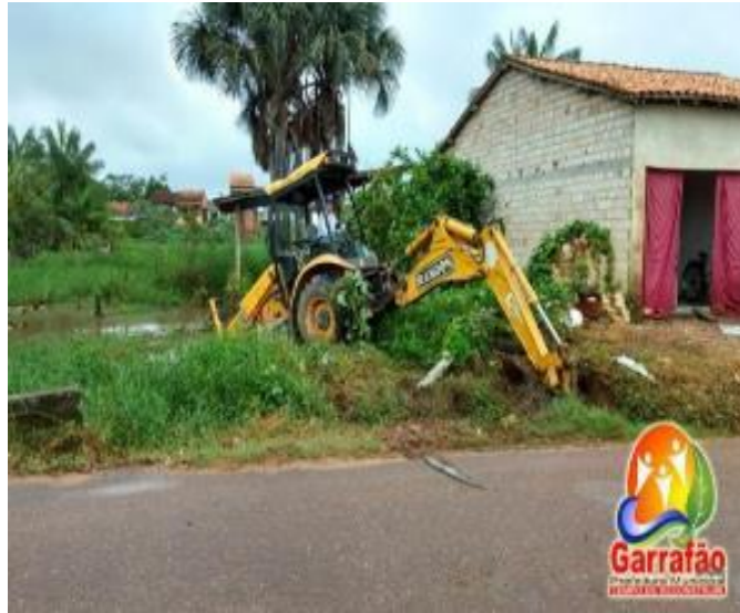
Figura 7 – Limpeza e desobstrução do Igarapé Garrafão
