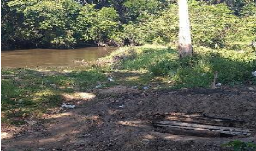
Figura 22 – Caieira localizada no leito de inundação da confluência do rio e do igarapé, bairro Centro
