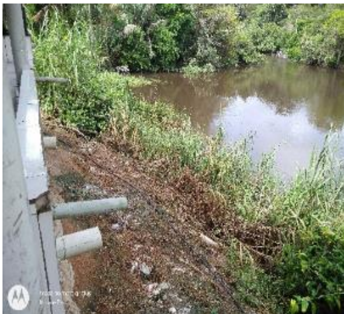
Figura 52 – Fundos do Matadouro Municipal na margem direita do rio Jipuúba (a)
