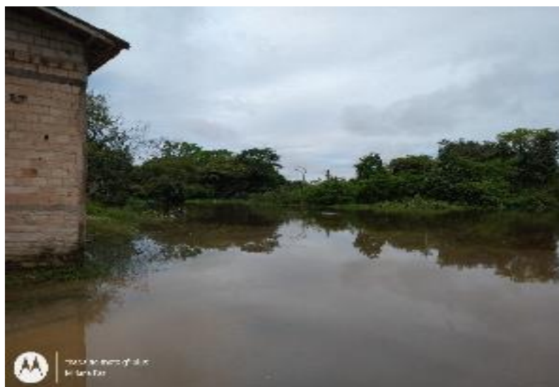
Figura 48 – Prédio residencial no leito maior (margem direita) do rio Jipuúba, no bairro Centro
