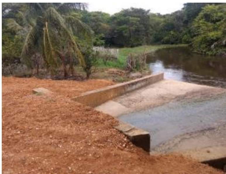
Figura 51 – Despejo de esgoto no leito e aterro na margem direita do rio Jipuúba
