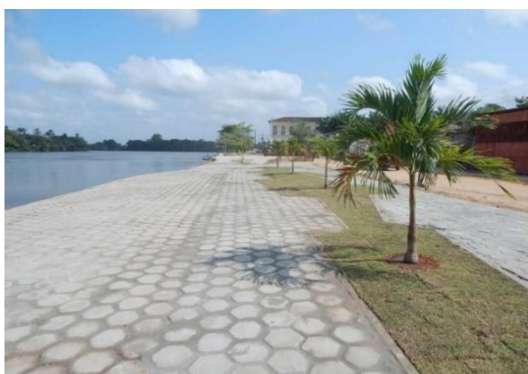
FIGURA 33: O espaço após a construção da orla fluvial
