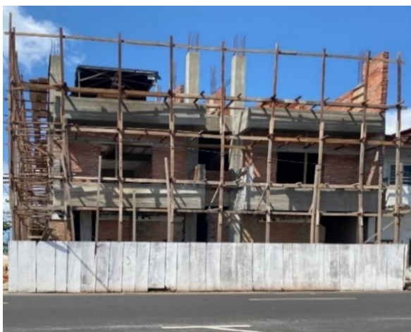
FIGURA 50: Construção do hotel às margens do Rio Guamá
