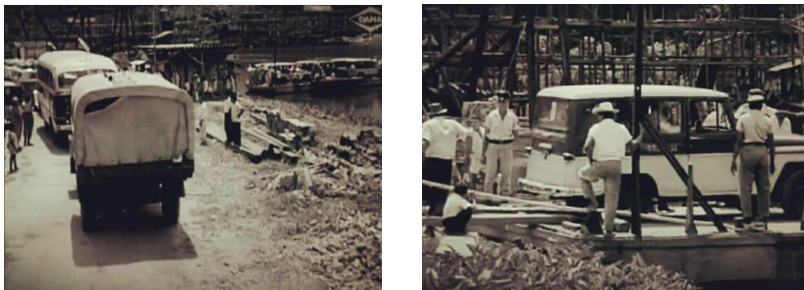
FIGURA 16: Início da construção da ponte “Dr. Waldir Bouhid ”
