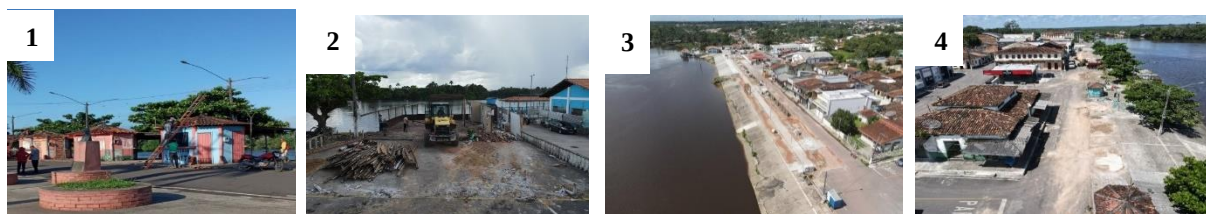
FIGURA 34: A demolição dos quiosques
