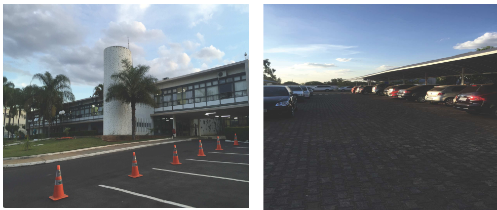
Figura 52 - Estacionamento de livre acesso ao público na VIJ TJDFT.
