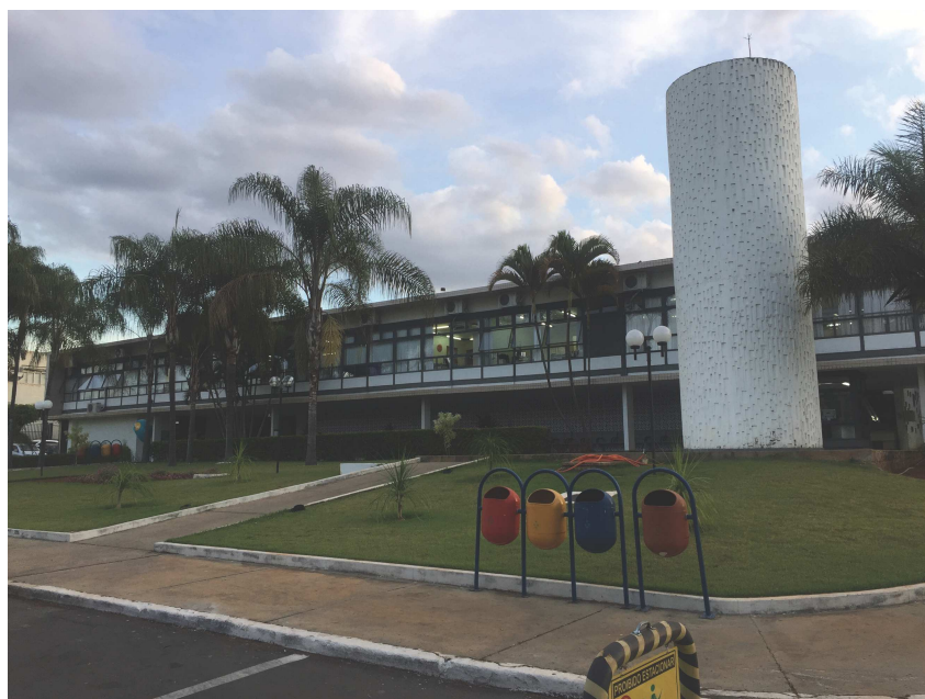
Figura 30 –Fachada Principal da VIJ TJDFT. Fonte: arquivo pessoal.
