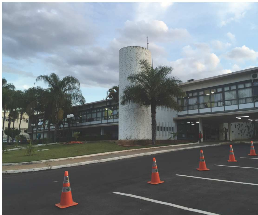
Figura 11 - Controle externo de acesso em uma VIJ. Fonte: Arquivo pessoal.
