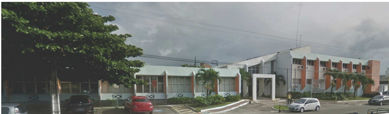
Figura 38 – Fachada frontal VIJ TJSE. Fonte: arquivo pessoal.
