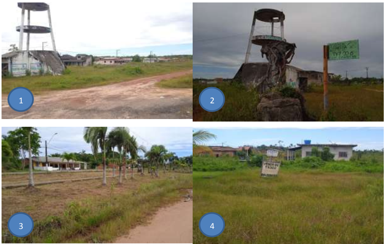
Figura 23- Residencial Portal da Ilha em Mosqueiro. 2022. Fonte: Pesquisa de campo.
