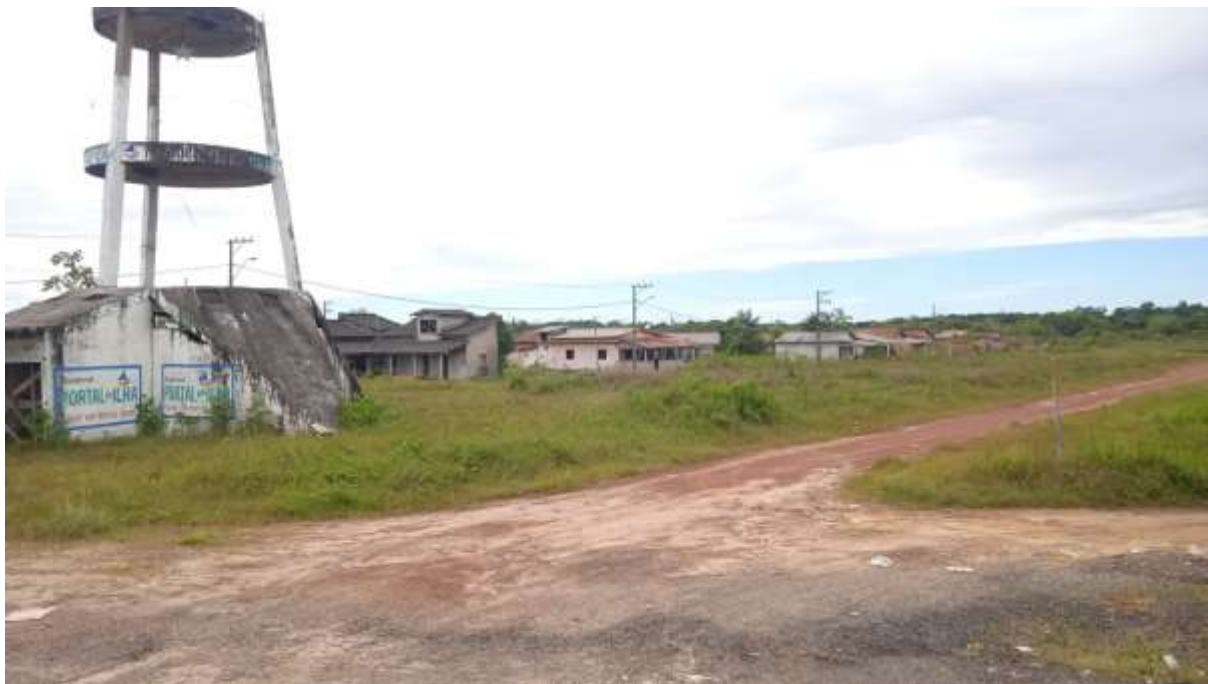
Figura 20- Residencial Portal da Ilha em Mosqueiro. 2022. Fonte: Pesquisa de campo.
