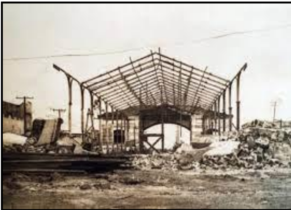
Figura 2- Castanhal. Demolição da Estação da ferrovia EFB. 1966
